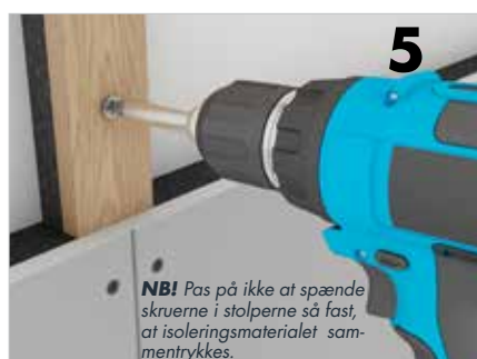
5. Stolperne placeres med en indbyrdes afstand på 550 mm og fastgøres med skruer pr. 600 mm lodret. Elementet fastgøres med skruer RA 25 med en afstand på 200 mm.
